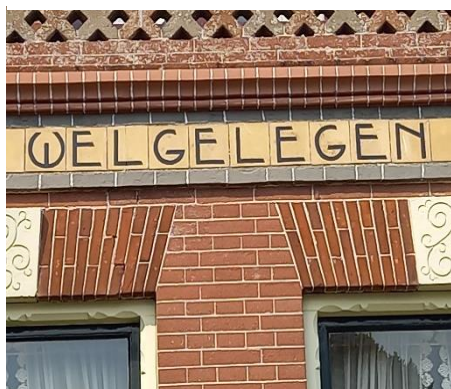
Welgelegen voorzien van nieuwe laag verf.
